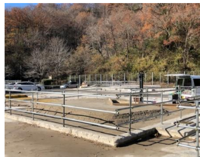
換気立坑埋め戻し完了後の状況 (2021.12.9)
