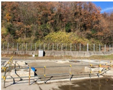
主立坑埋め戻し完了後の状況 (2021.12.9)
