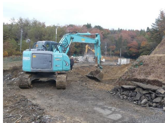
基礎撤去の状況(2021年11月)
