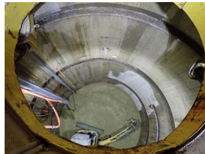
換気立坑深度 90m 付近 (2021.4.7)
